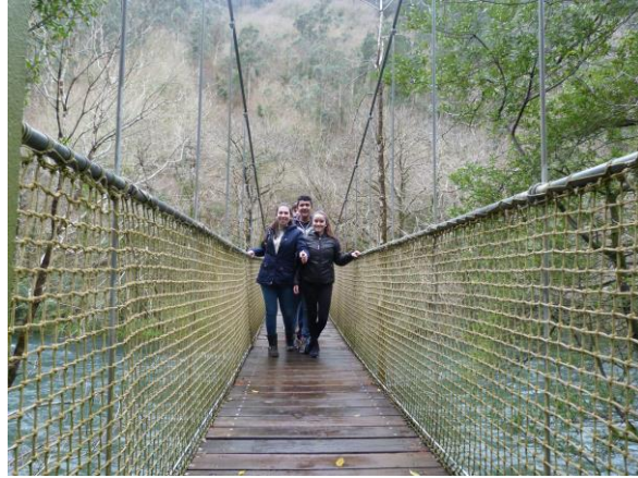
Ponte colgante sobre o río Eume.
